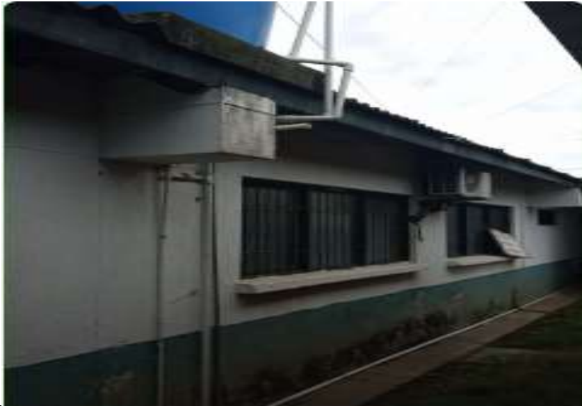
Actividad: arreglo e instalación de nueva acometida de agua Lugar: sede Jorge Eliecer Gaitán
